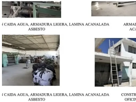
ARMADURA LIGERA, LAMINA ACANALADA ASBESTO
